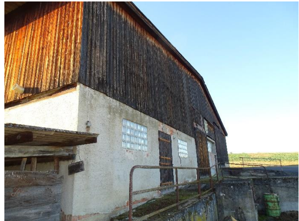
Abb. 10: Stallung mit Holzverkleidung des Hofes In den Huzelgärten 20
