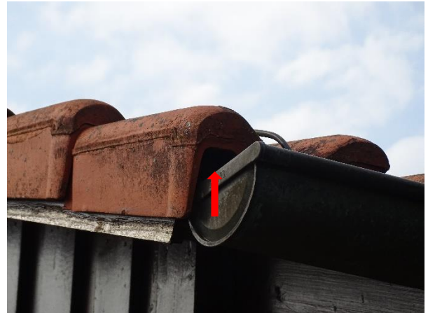
Abb. 9: Öffnung unter den Dachziegeln (roter Pfeil)
